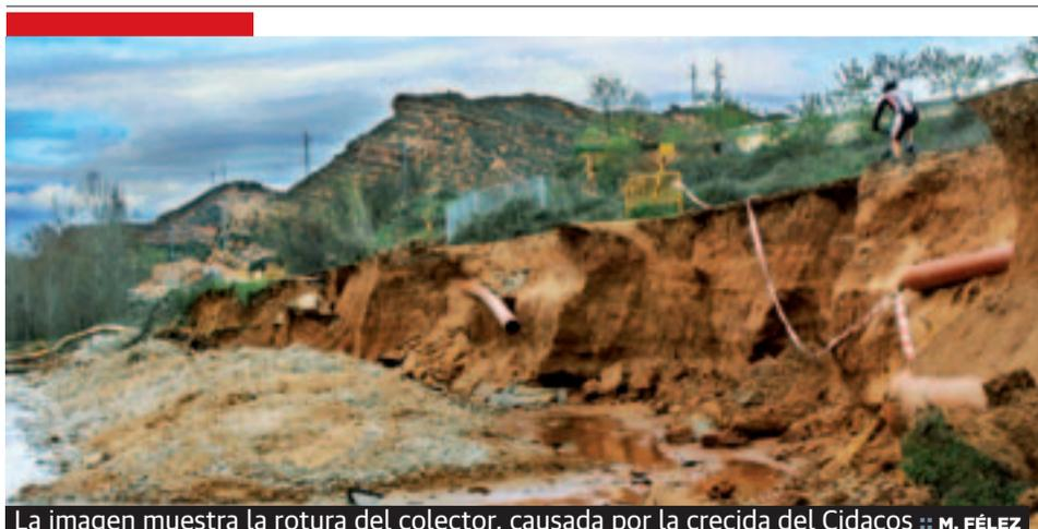
La imagen muestra la rotura del colector, causada por la crecida del Cidacos :: **M. FÉLEZ**
