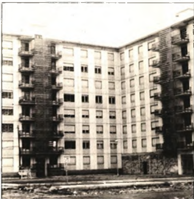
Un 7,86 por ciento de las viviendas riojanas tienen vías deficientemente pavimentadas
