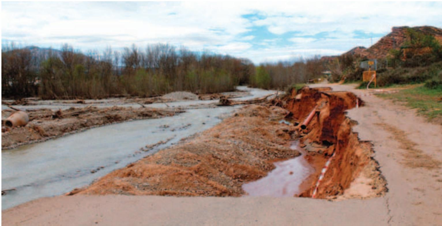
Zona donde impactó el río causando la rotura del colector de residuales y de la Vía Verde, como se aprecia en la imagen. :: M.FÉLEZ
